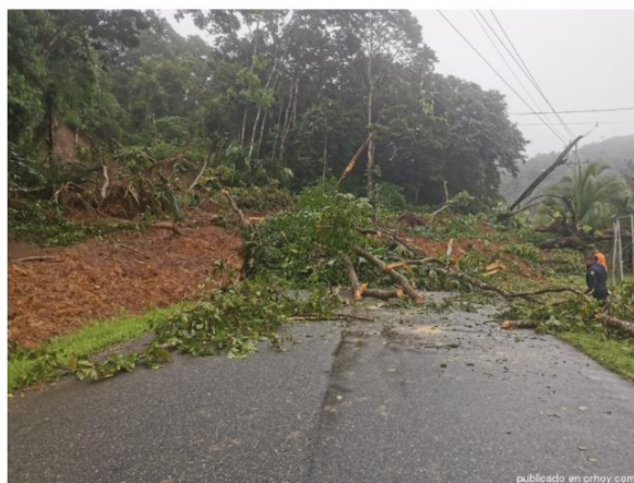
Ruta 238, en Golfito, también con afectación. MOPT
